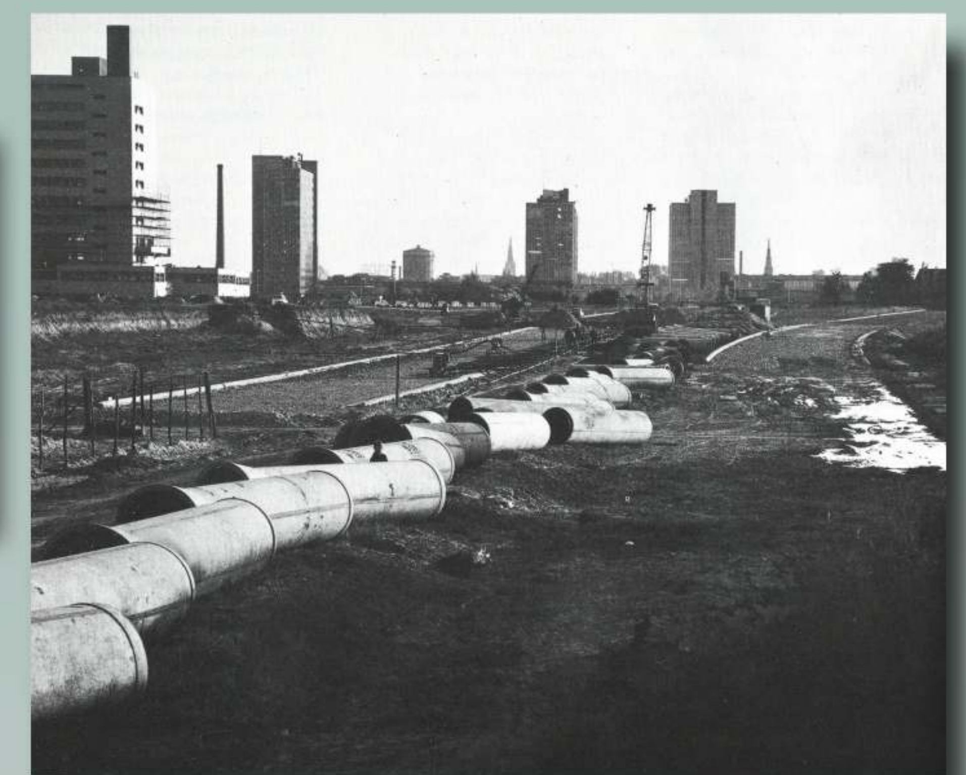
Aanleg van de John F. Kennedylaan.
