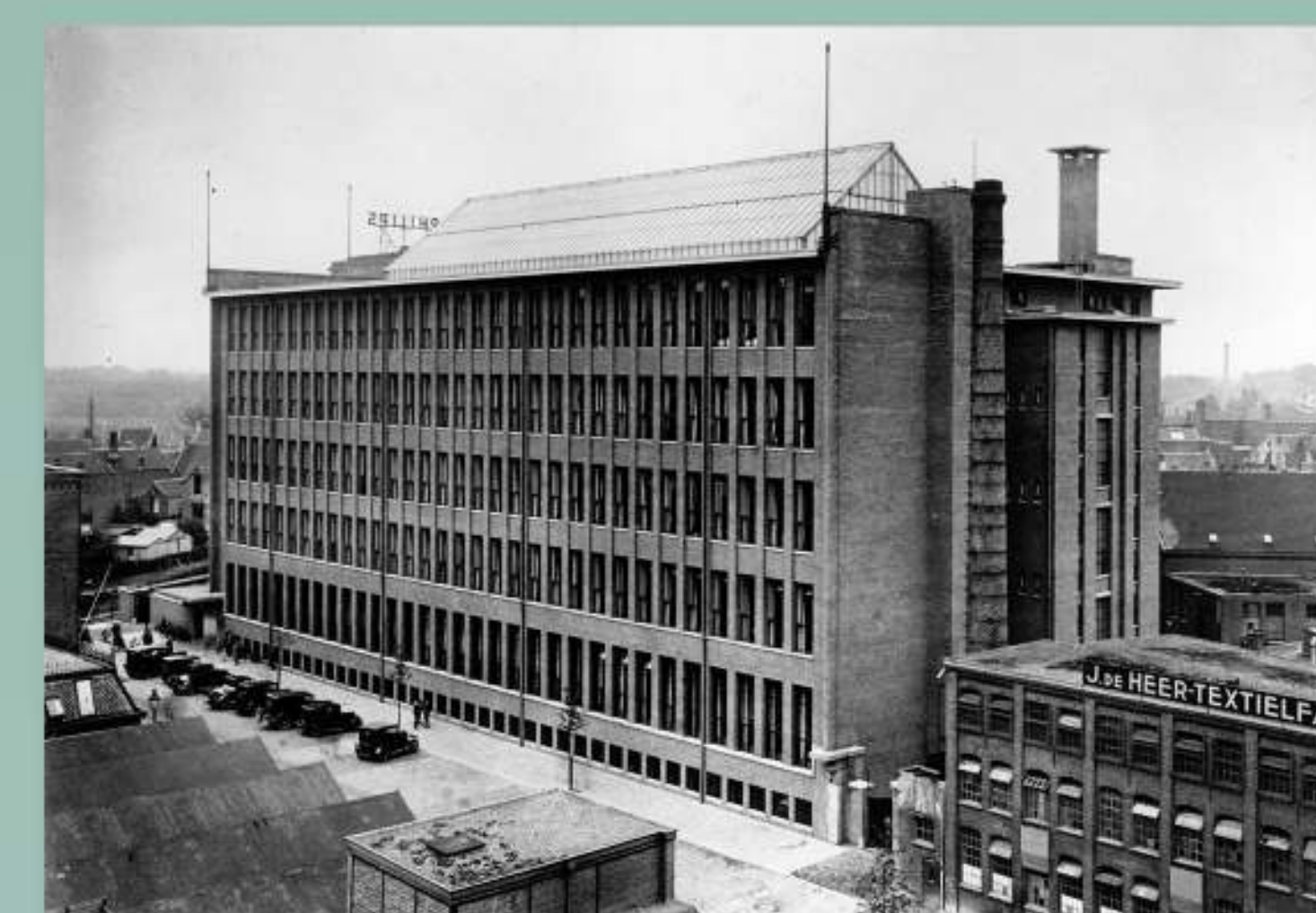
Ook op de Emmasingel hebben textiel fabrieken gestaan. Het gebouw rechts onderaan is de textiel fabriek van J. de Heer. Het nieuwe hoofdkantoor van Philips staat er dreigend naast.
