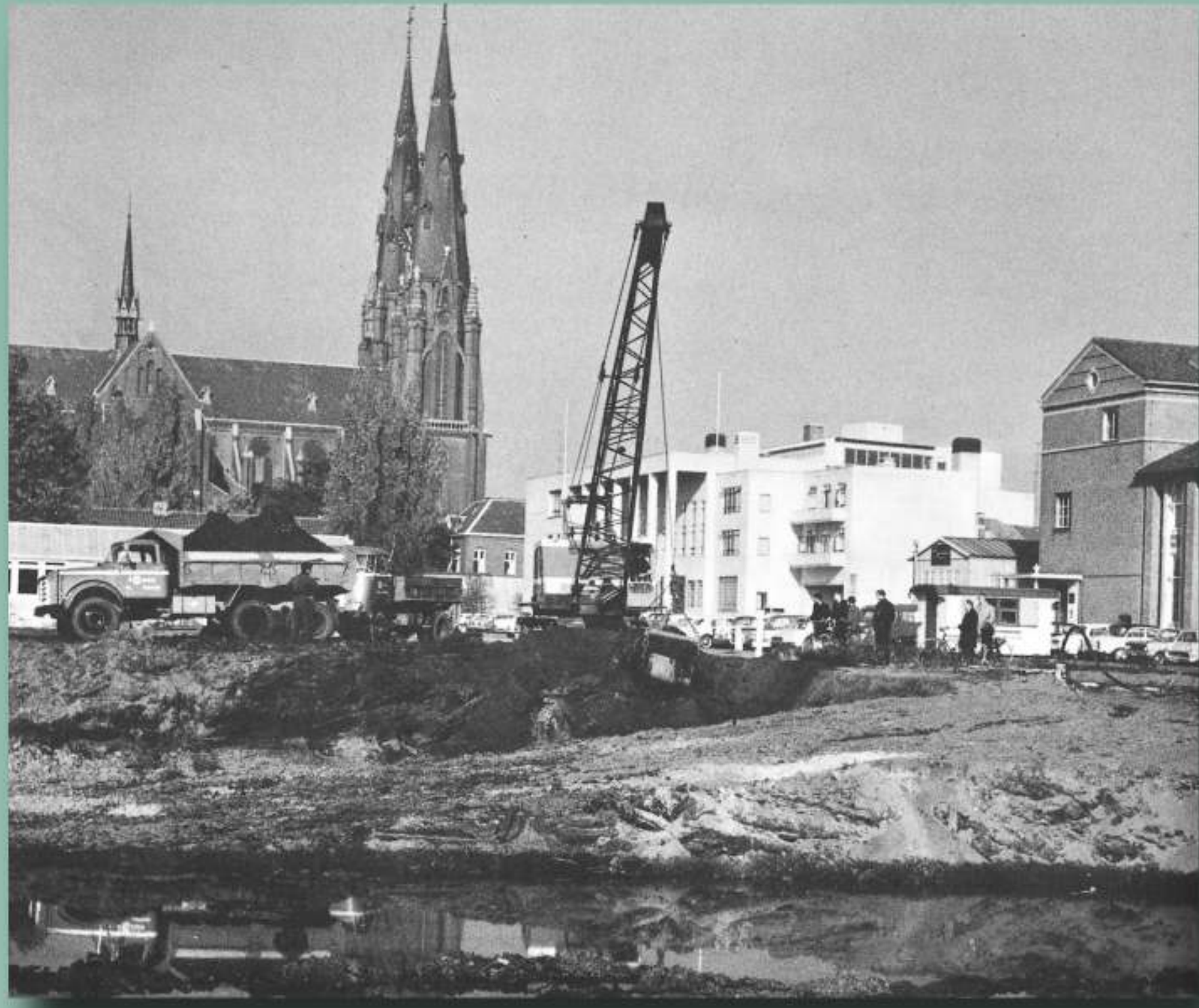
Het nieuwe gemeentehuis van Eindhoven in aanbouw.
