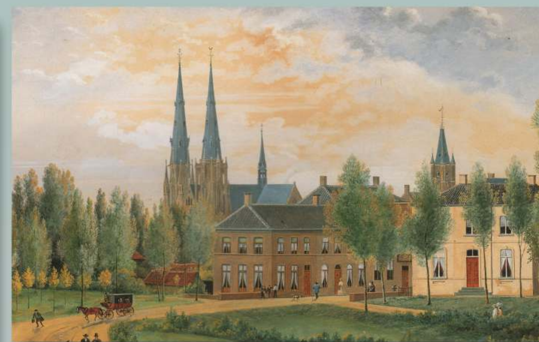
Zicht op de stad vanaf het station in 1870
