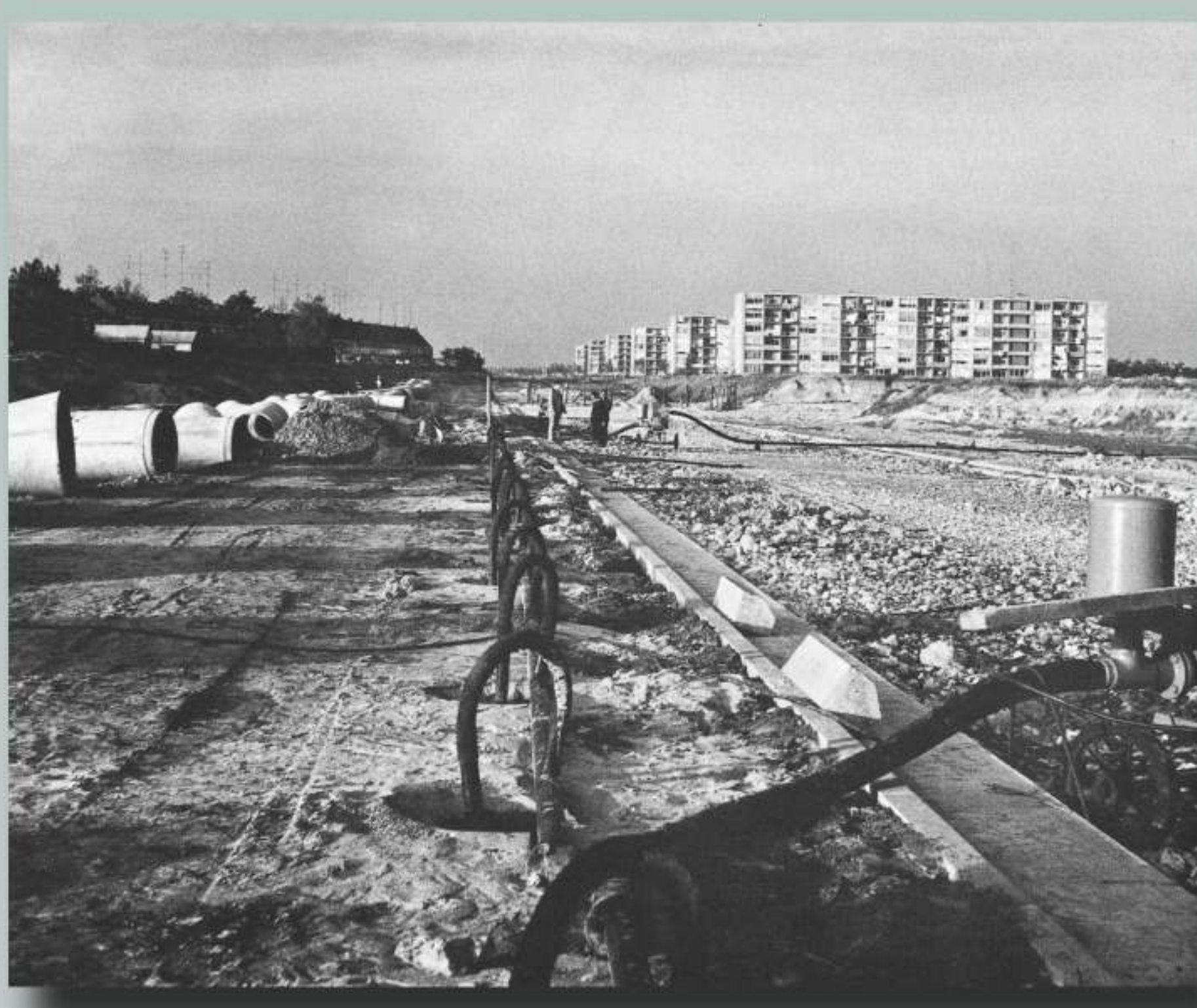
Bouwactiviteiten in Woensel.
