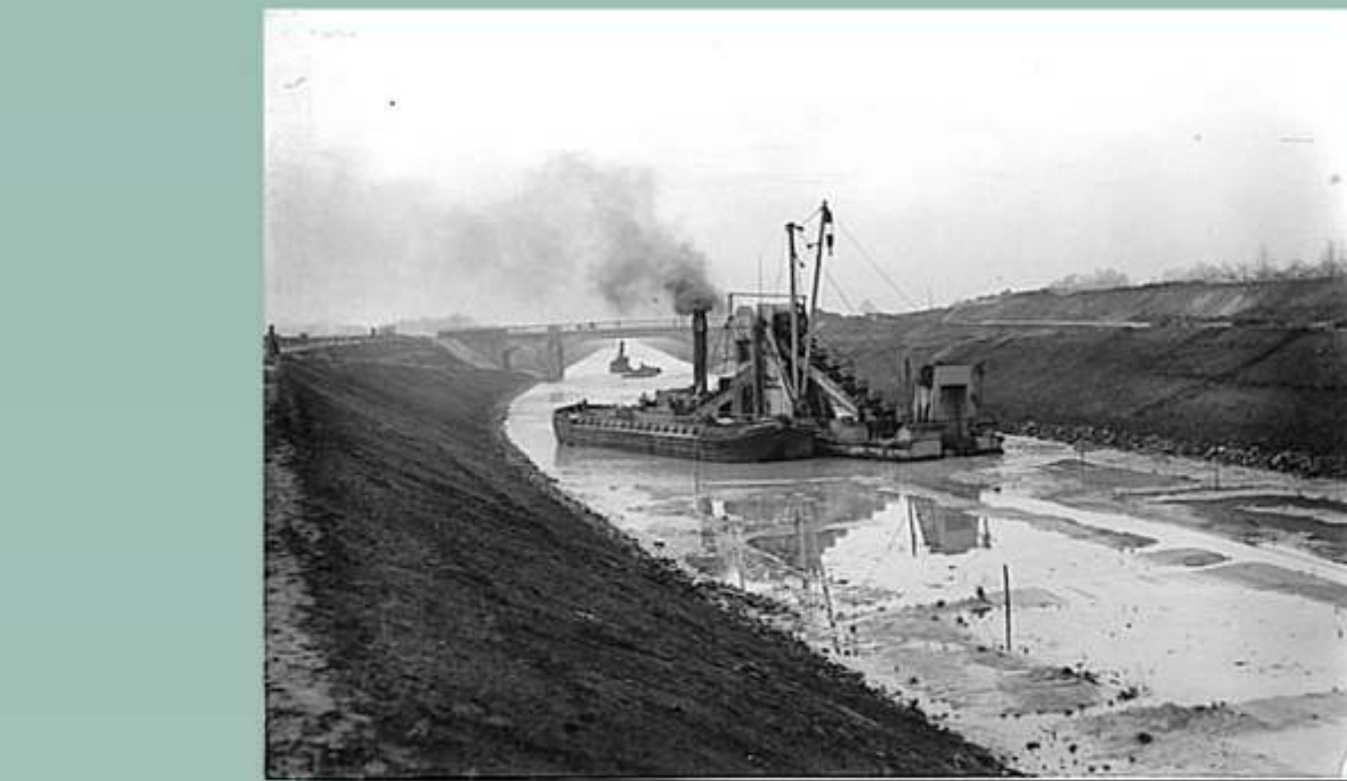
Het graven van het Beatrixkanaal in 1938. Het graven gebeurde meest machinaal, eerst met twee imposante graafmachines en daarna met deze baggerschuit. De brug op de achtergrond is van de Eindhovensedijk. Rondom de nieuwe haven is een nieuw industriegebied gepland. Dit moet ervoor zorgen dat er geen nieuwe industriecomplexen in het centrum van de stad worden gebouwd.
